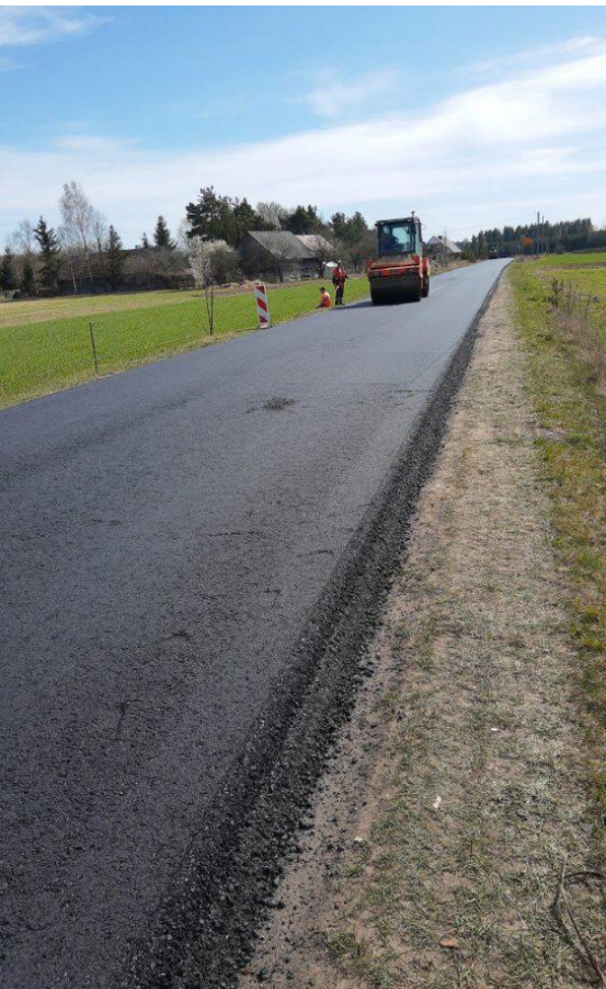
Przebudowa drogi w Kobylance, obwodnica Michałowa
